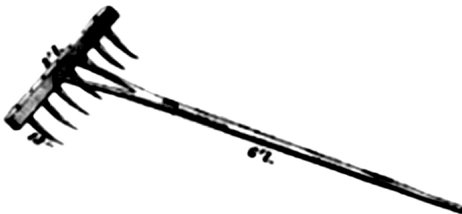
Harke mit eisernen Zinken, zum Kohlenziehen
