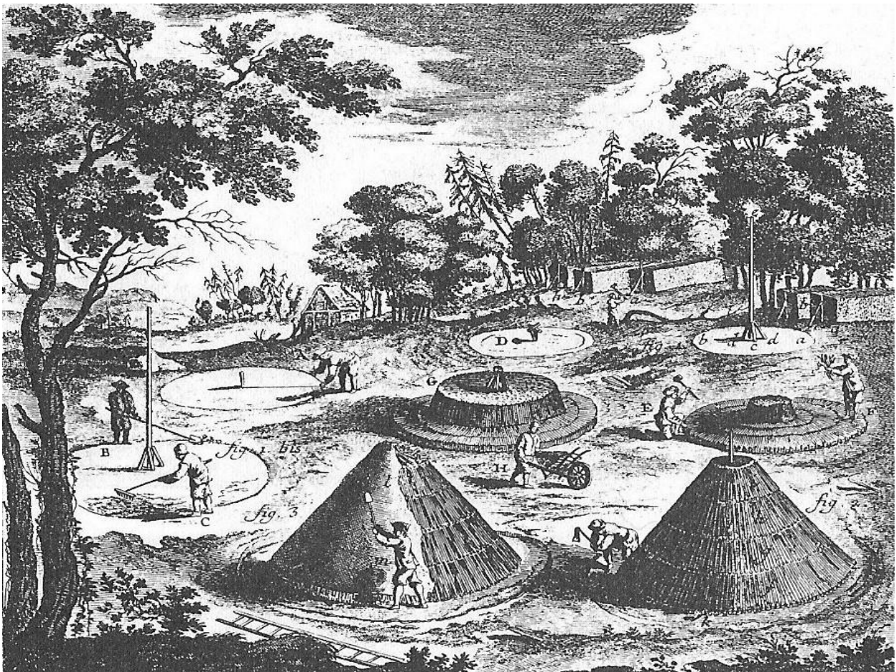
Abb. 1: Köhler beim Betreiben einer Kohlstätte, acht Meiler sind in verschiedenen Fortschrittsstufen im Aufbau
